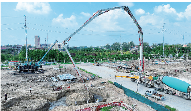
丰德康项目建设现场。记者徐松摄
