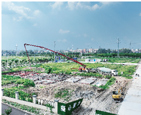
天存种业项目建设现场。记者徐松摄
