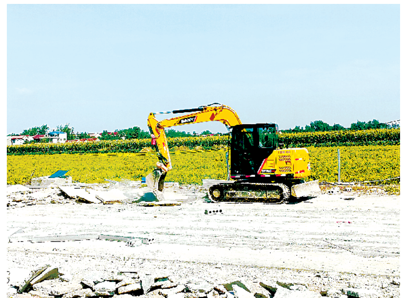
8月24日上午,鹿邑县玄武镇组织镇执法大队、镇国土所对郝庄预制板厂进行拆除。据了解,该预制板厂以铁皮当围墙,既存在安全隐患又影响环境面貌。今年以来,玄武镇推进土地增减挂钩实施与整治空心村、取缔散乱污企业、整治农村人居环境工作有机结合,规定行政村每完成1亩土地增减挂钩指标任务奖励2万元。截至目前,玄武镇已完成土地增减挂钩53亩。记者 侯国防 摄
